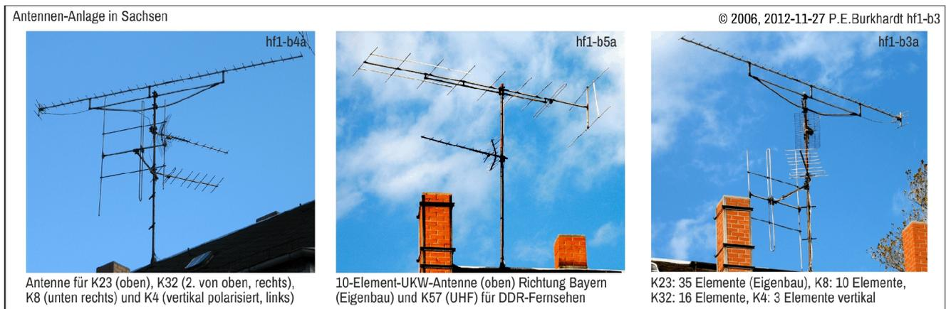
Mit Ausstrahlung der 2. Programme im UHF-Bereich wurde die Material-Situation noch verschärft. Zunehmend wurden Antennen, Verstärker, Filter und letztlich auch ganze Antennenanlagen privat beschafft, selbst hergestellt und errichtet. Wer nicht selbst das Wissen oder die Möglichkeit dieser Selbsthilfe hatte, beauftragte eben Bekannte, die dies konnten.
